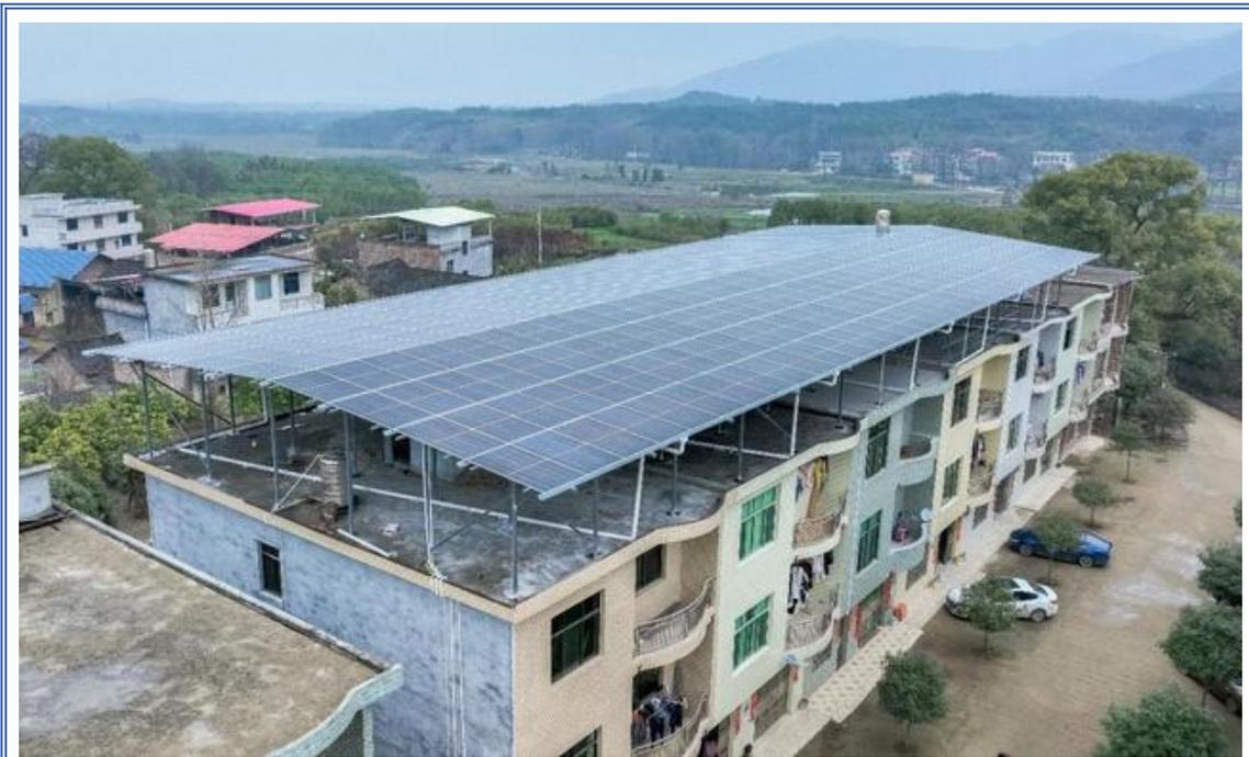
BIPV搭棚方式示意图
