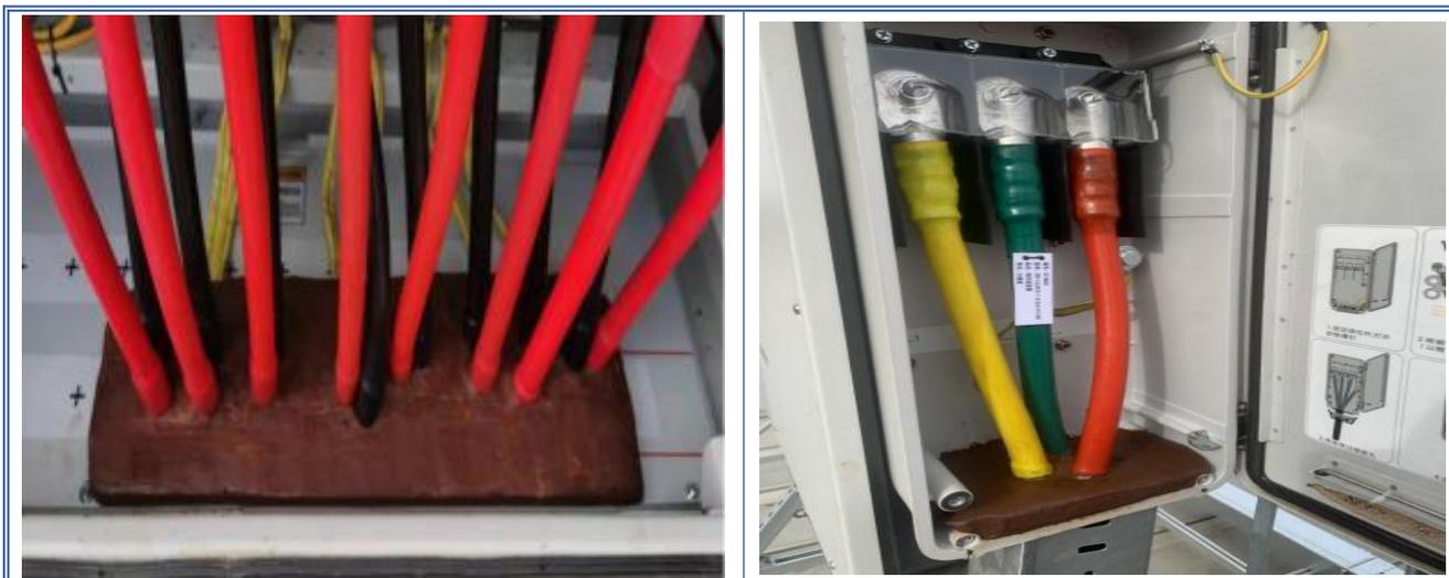
电缆防火封堵敷设示意图
