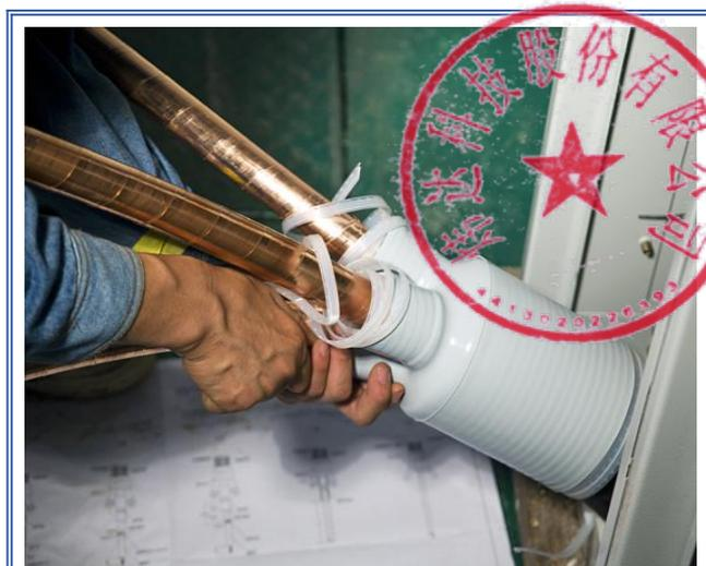
电缆安装三叉手套示意图
