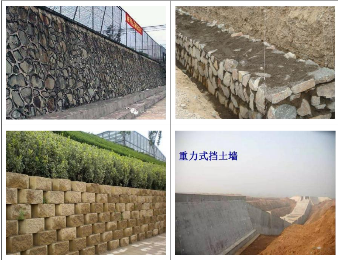
图 4.5.3-1 常用重力式挡墙
