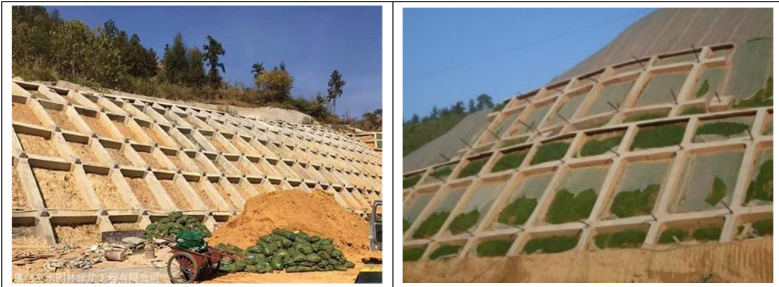
图 4.5.3-4 垛式（框架式）挡土墙
