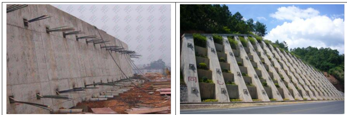
图 4.5.3-3 锚固式挡土墙
