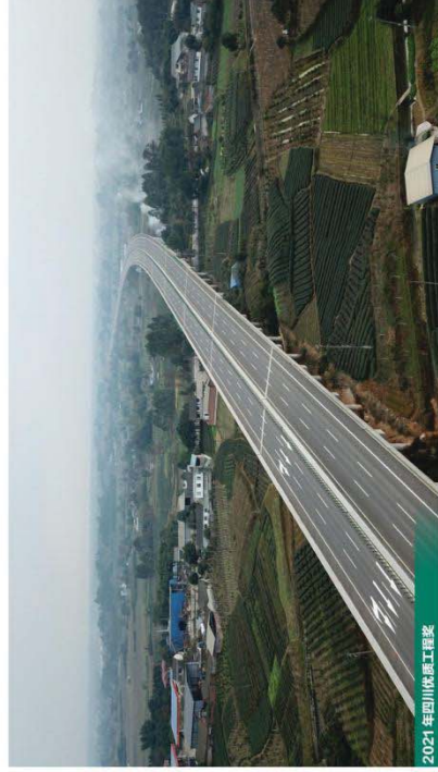
▲滇南高速都江特大桥 全长6464.5米，主桥共有53墩，有259跨，2520片预制箱梁，均采用25米标准跨径预制结构，钻孔灌注桩设计1048根。2022年12月，该工程被授予四川“天府杯”奖（省级优质工程）。
