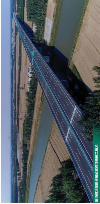
▲青兰高速东阿至聊城段首次顶推特大桥 上部结构为桁梁组合连续梁，跨径为57+59+57米，桥长183.18米，总宽为38.0米，分左右幅，中心线宽为2.7米。主桥由顶板、底板、腹板、横隔板及挑梁通过焊接形成钢梁。大桥是国内首次采用步履式双向顶推施工技术，为今后同类施工提供了监理工作经验。
