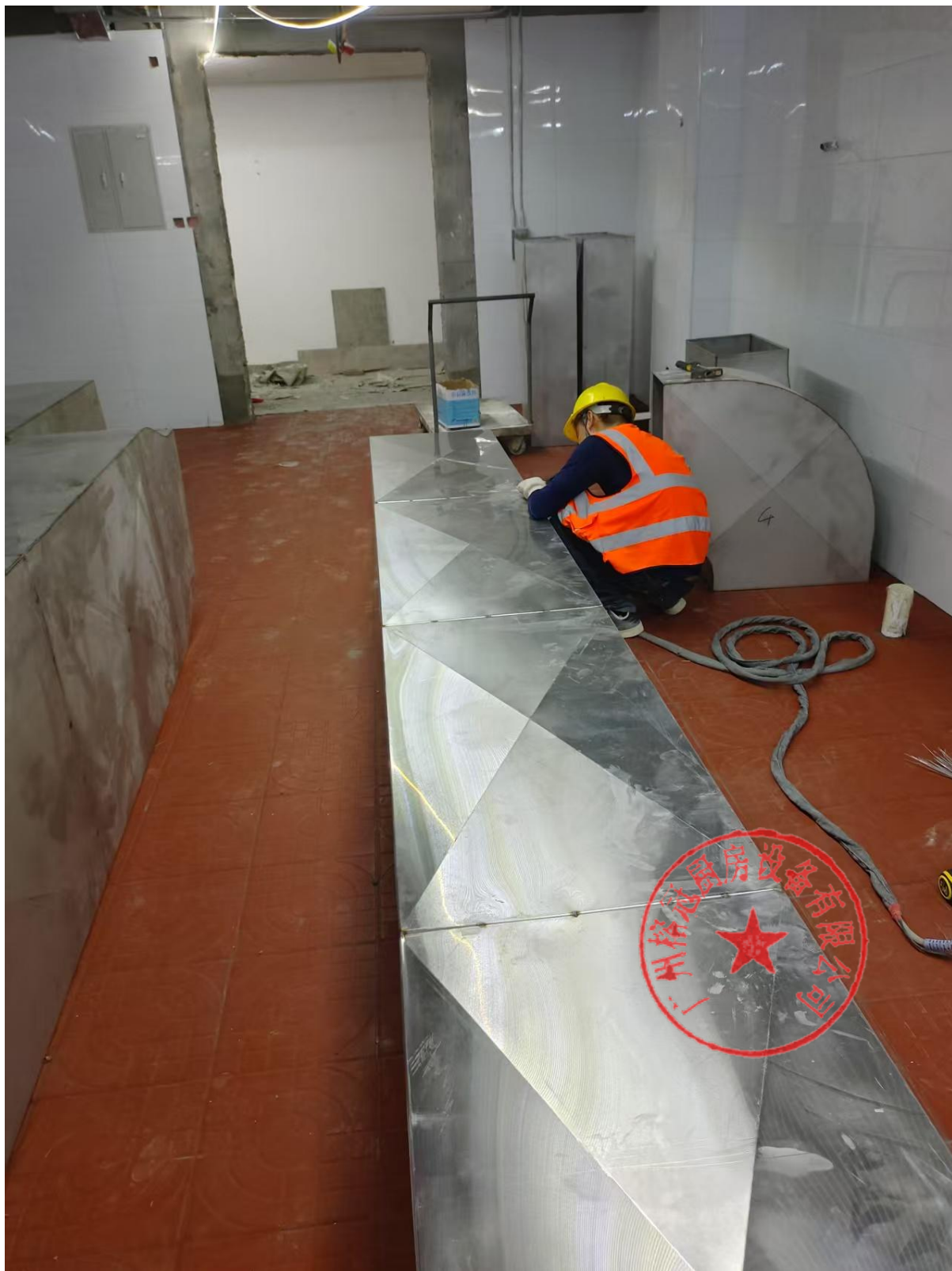
风管安装示意图
