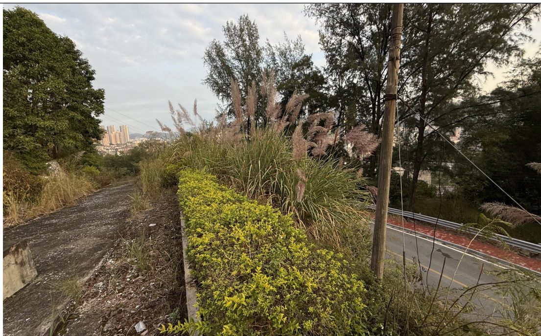
图 3-6 现状挡土墙（清杂及修葺）
