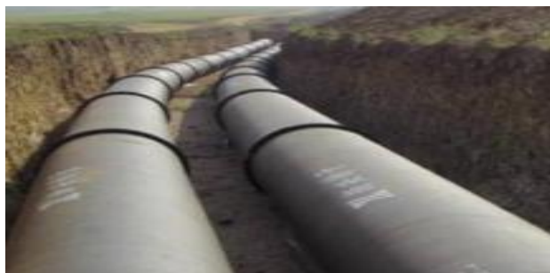
图 5-1-2 球墨铸铁管
