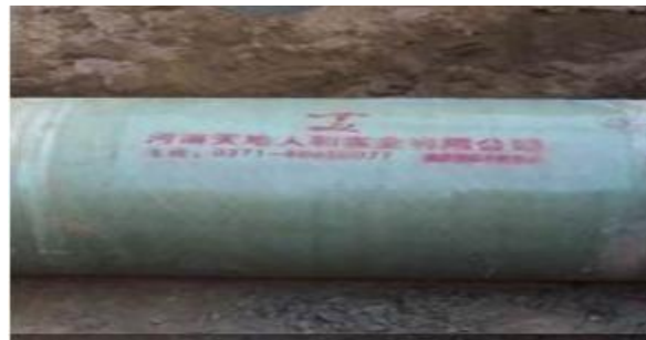
图 5-1-4 玻璃钢砂夹管
