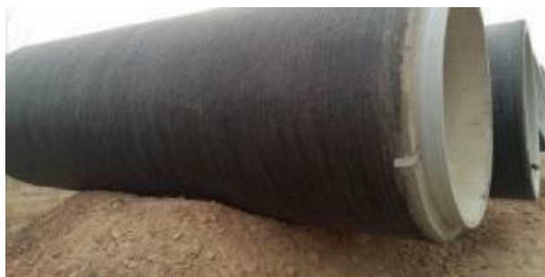
图 5-1-3 预应力钢筋混凝土管
