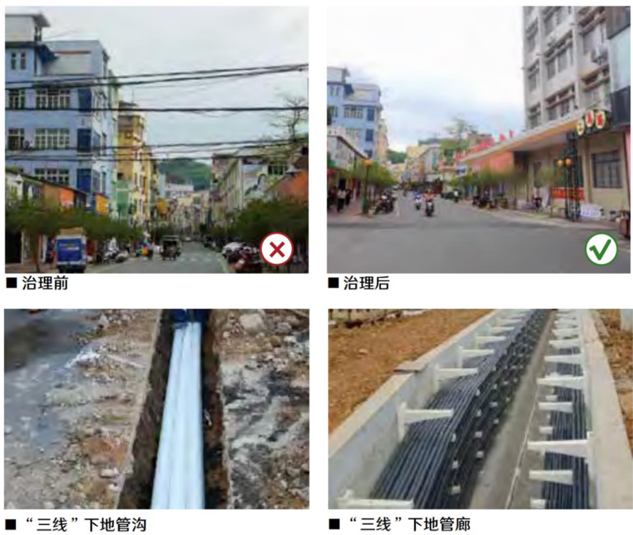
图6.2-28: “三线”整治效果示意图
