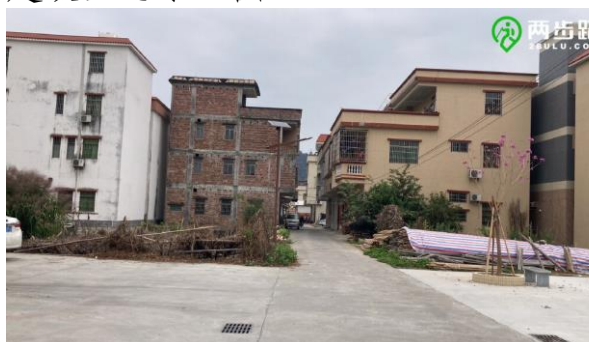
房屋风貌提升
