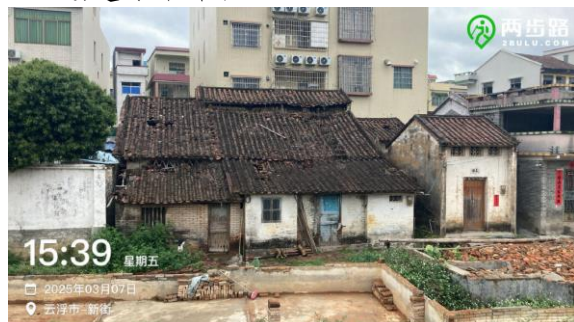
闲置旧屋及地基拆除，改造生态空间
