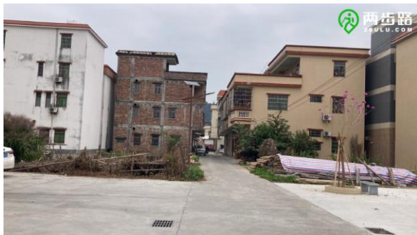
广场增设宣传栏，房屋风貌提升
