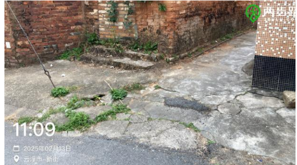
道路破损修复
