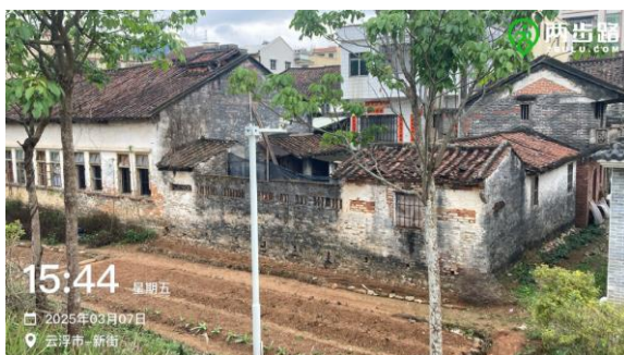
屋顶修缮、风貌提升
