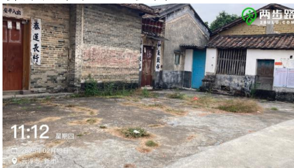
地坪路面提升
