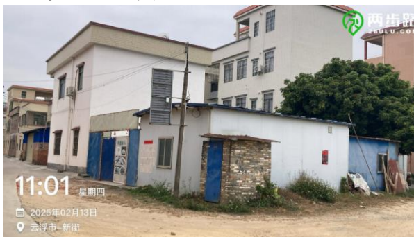
房屋风貌提升
