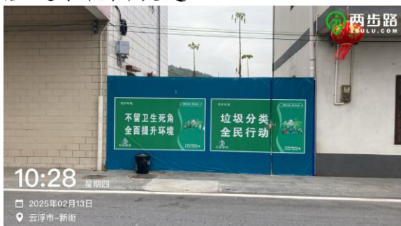
拆除围蔽改生态空间
