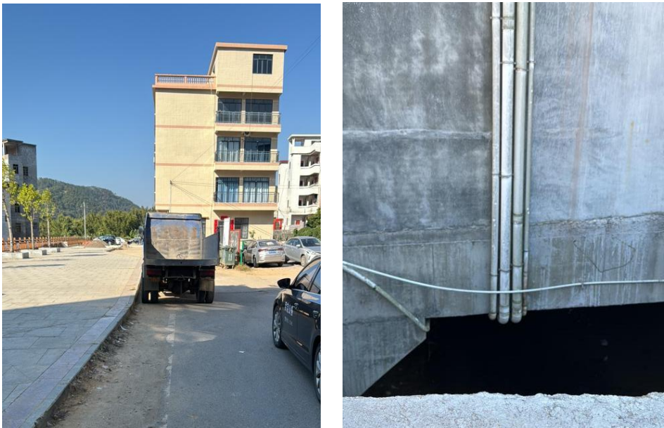
图 5.3-31 部分排水现场照片
