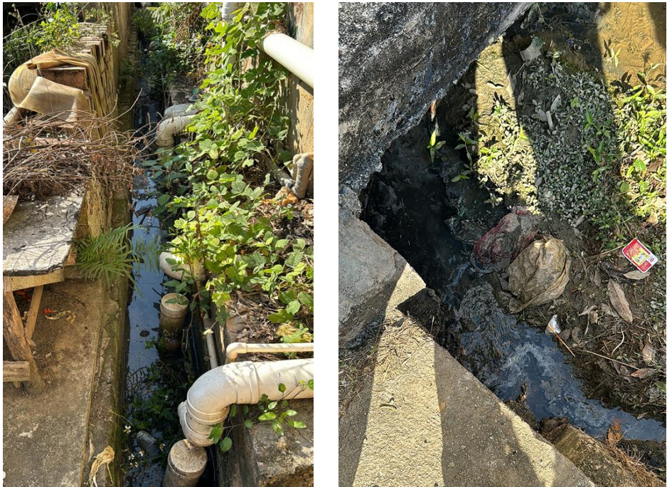
图 5.3-11 部分排水现场照片
