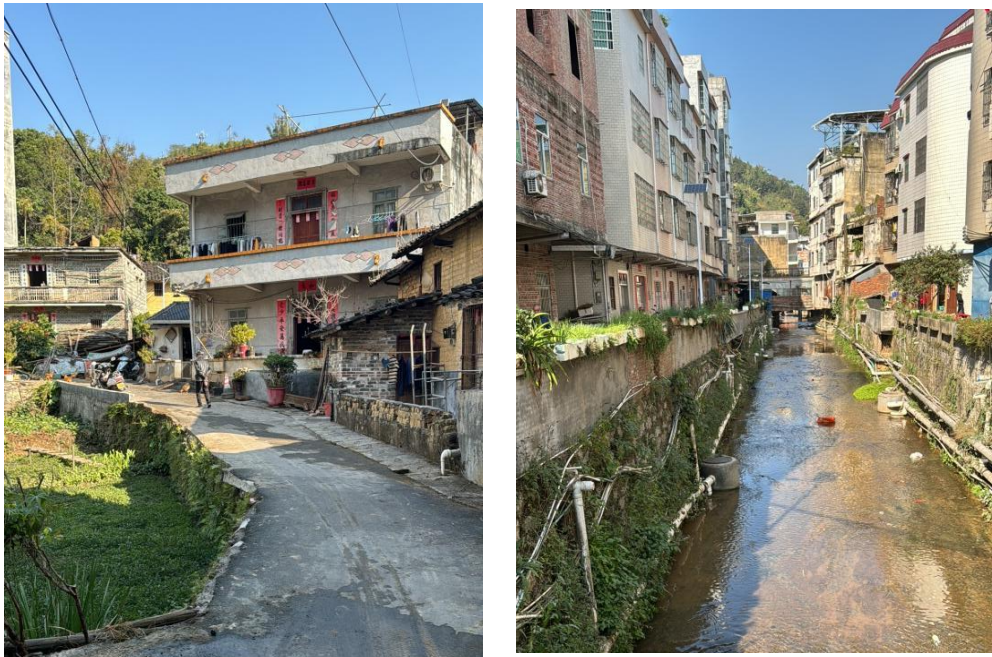
图 5.3-29 部分排水现场照片
