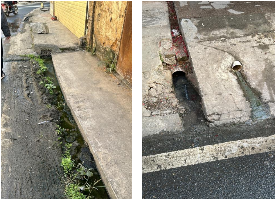
图 5.3-3 部分排水现场照片
