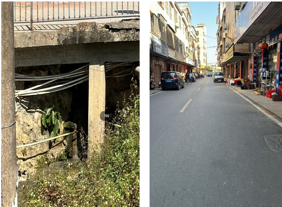
图 5.3-5 部分排水现场照片
