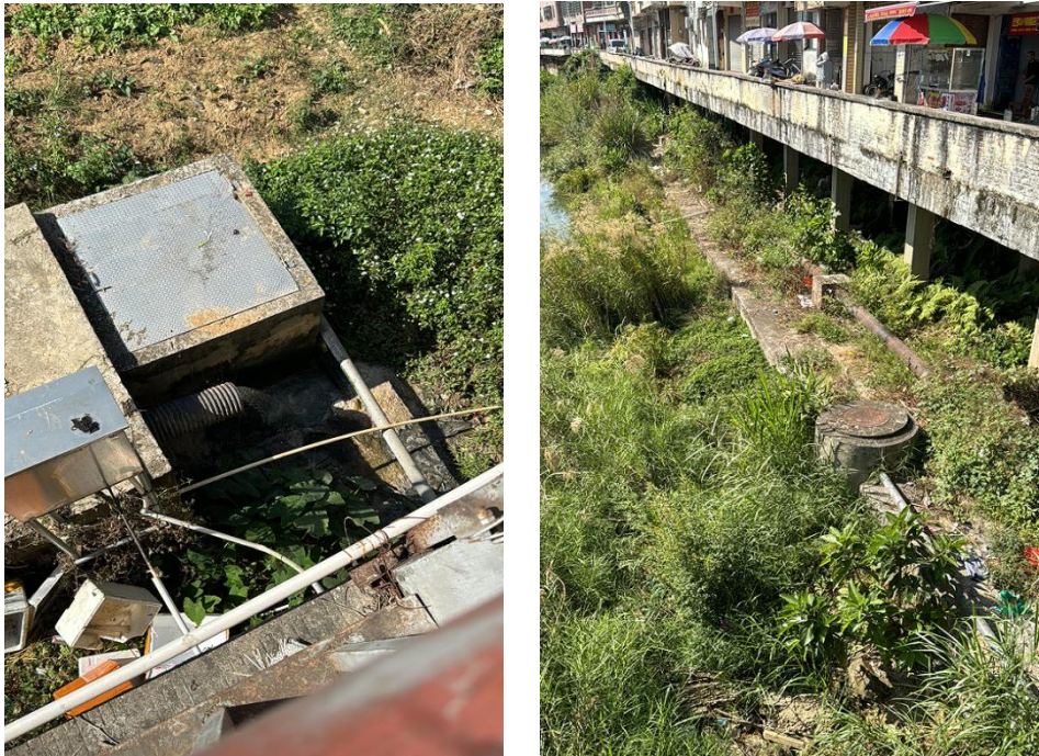
图 5.3-9 部分排水现场照片
