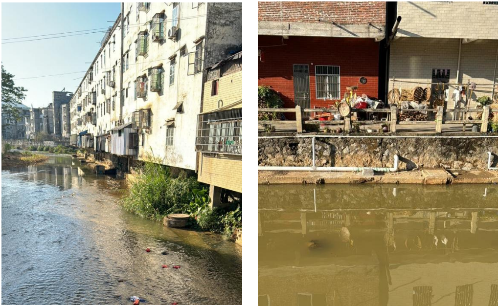
图 5.3-25 部分排水现场照片
