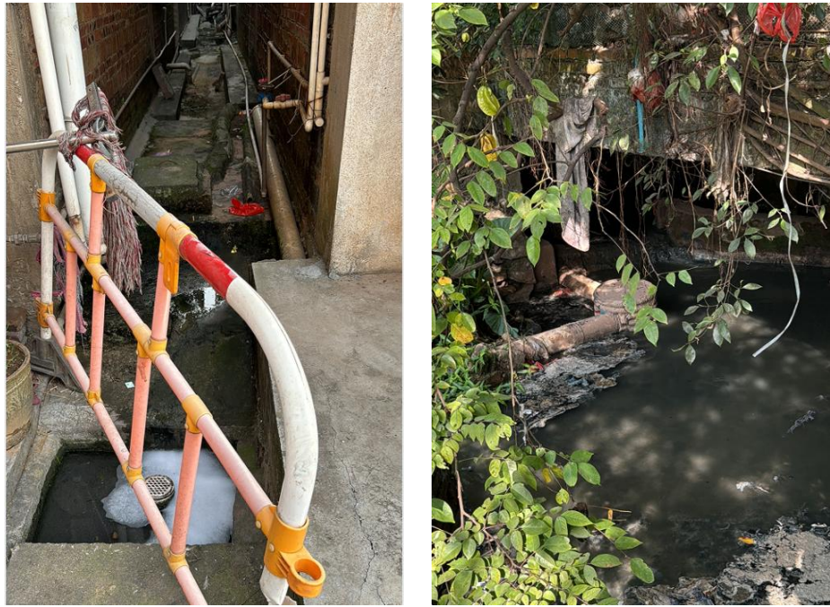
图 5.3-1 部分排水现场照片
