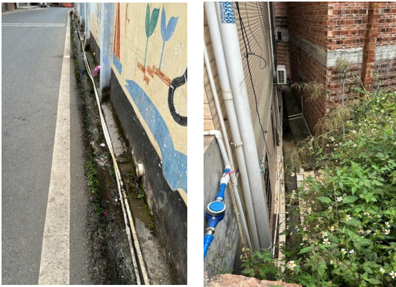
图 5.3-19 部分排水现场照片
