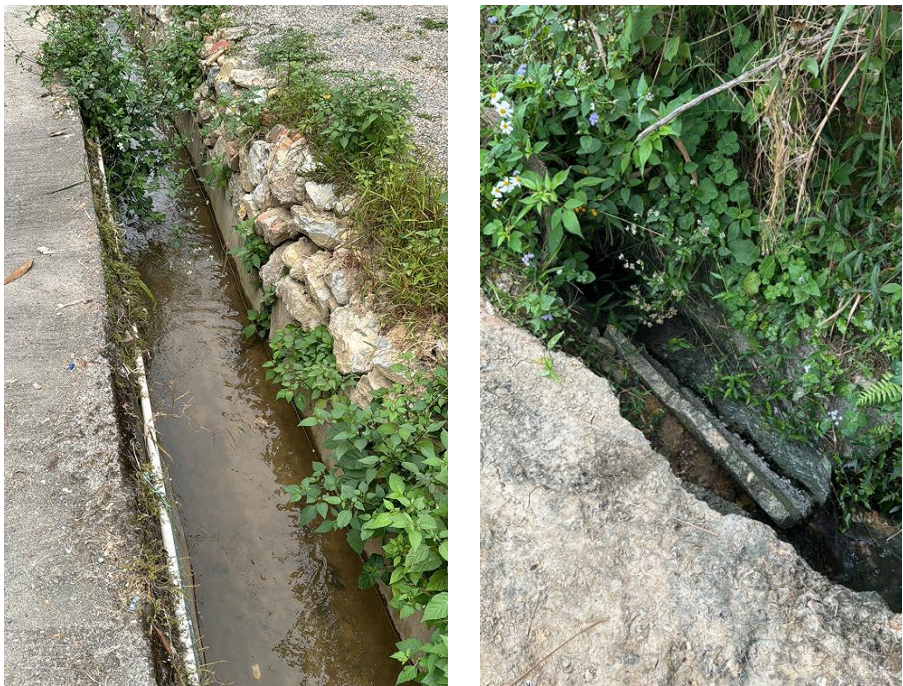
图 5.3-21 部分排水现场照片
