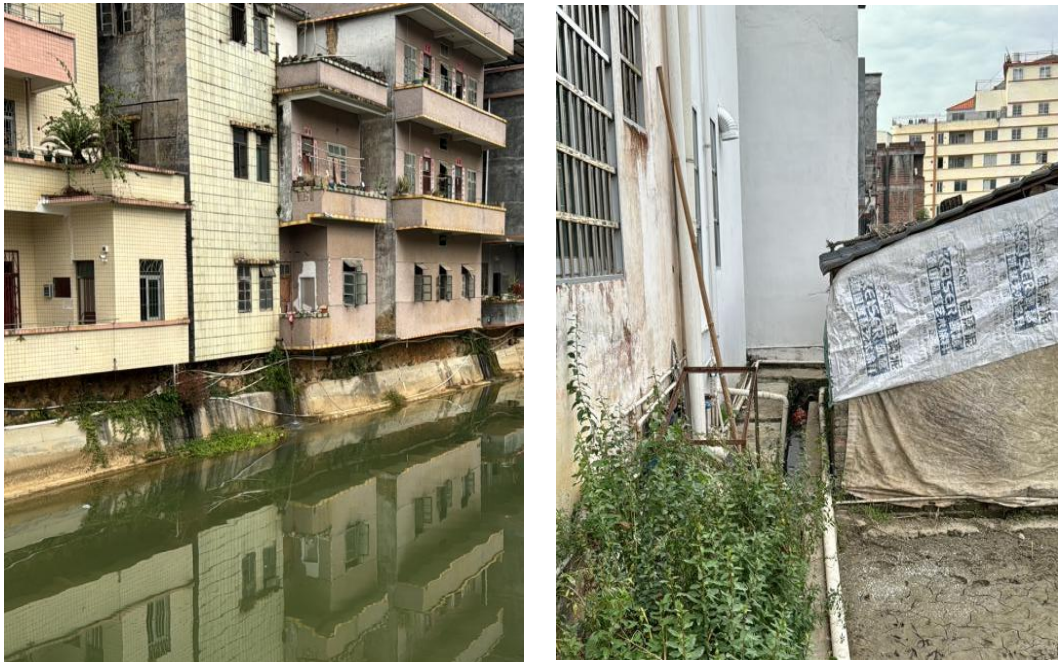
图 5.3-27 部分排水现场照片
