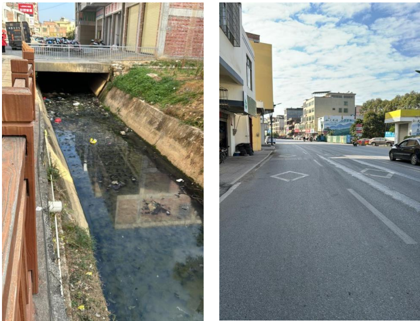
图 5.3-33 部分排水现场照片
